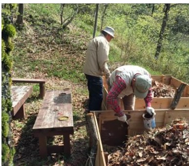
上部設置のオチバンク木枠に防腐塗装
